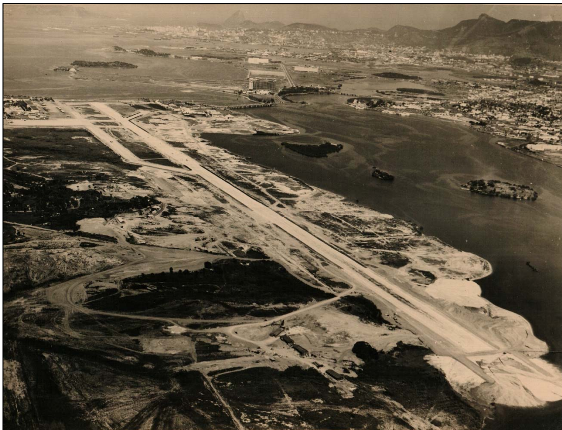
Obras de ampliação do Aeroporto Galeão na década de 1960. Fonte: CENDOC
