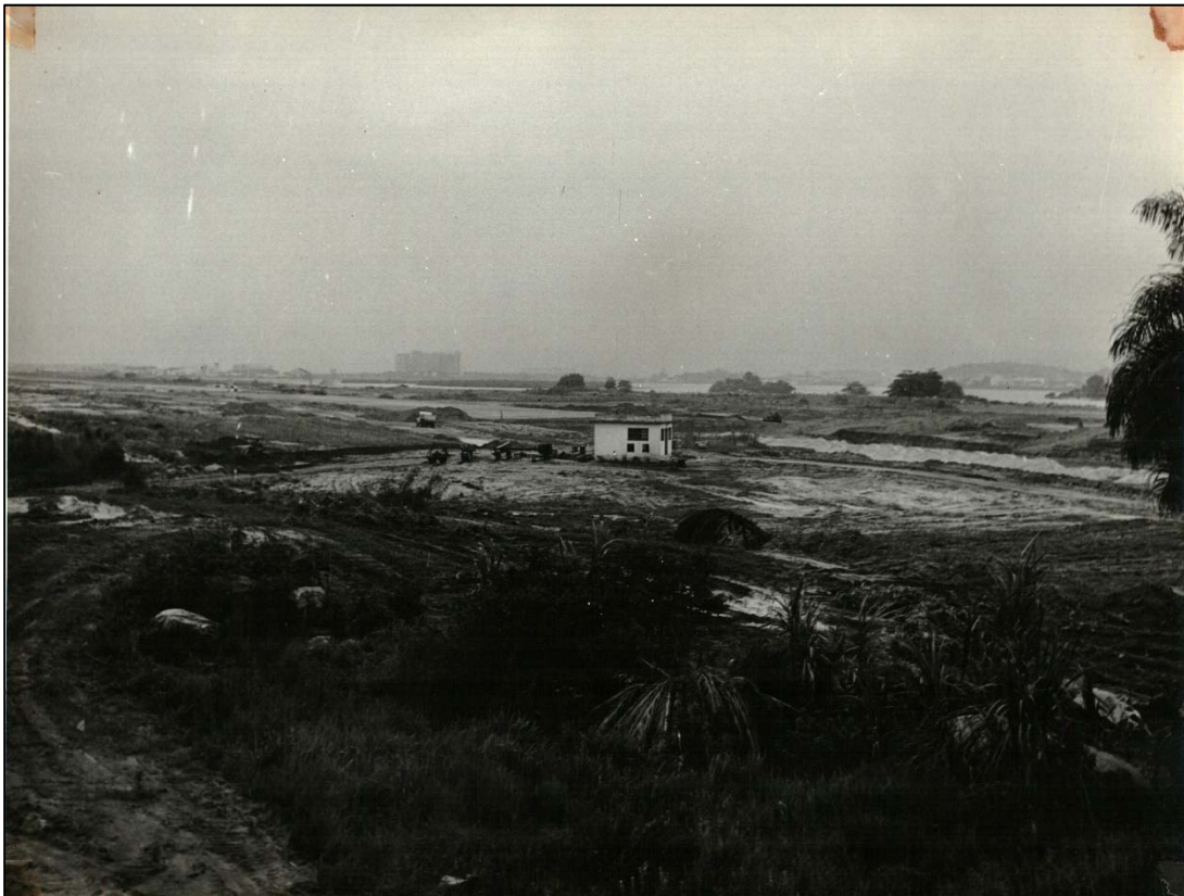
Obras de ampliação do Aeroporto Galeão na década de 1960. Fonte: CENDOC
